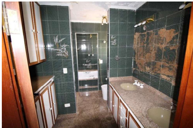
Foto 24 – 3º quarto/Suíte – Banheiro
