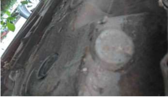
Foto Estrutura Assoalho
