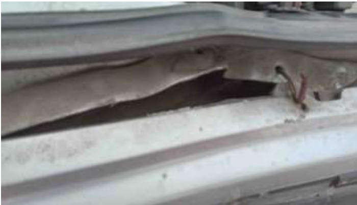
Foto Avaria Painel/Saia Traseiro
