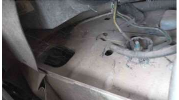
Foto Estrutura Longarina Direita
