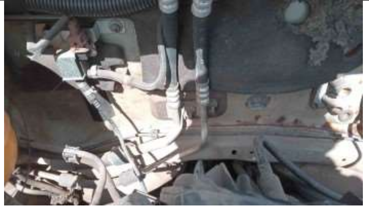
Foto Ar Condicionado
