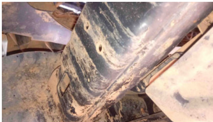
Foto Estrutura Longarina Esquerda
