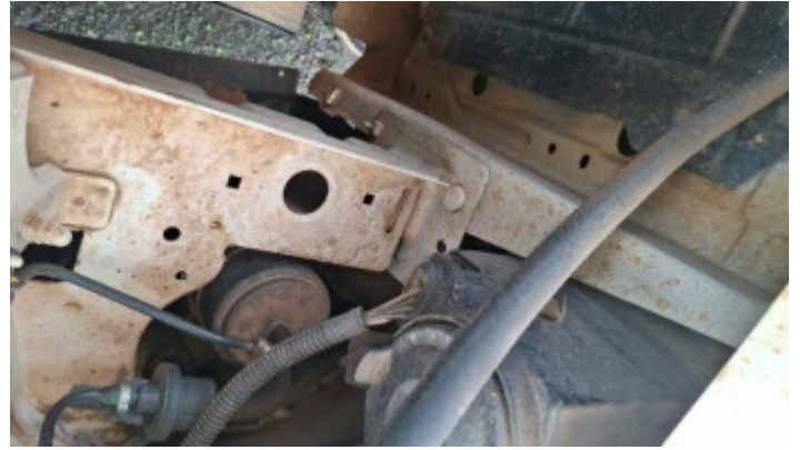
Foto Estrutura Longarina Direita
