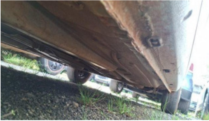
Foto Estrutura Assoalho
