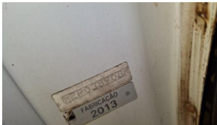
Foto etiqueta ETA (batente da porta)
