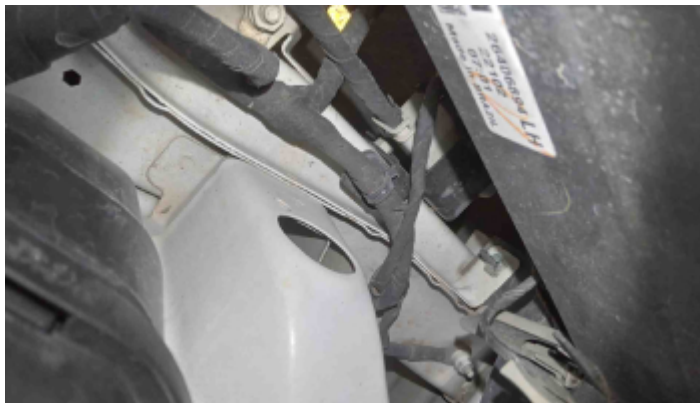
Foto Estrutura Longarina Esquerda
