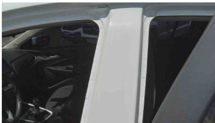
Foto Estrutura Coluna Central Esquerda
