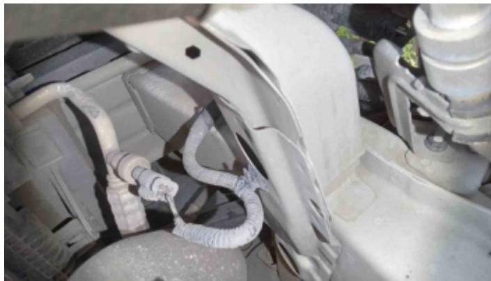
Foto Estrutura Longarina Direita
