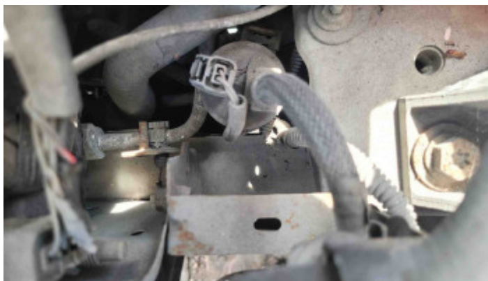
Foto Estrutura Longarina Direita
