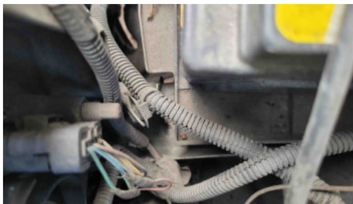
Foto Estrutura Longarina Esquerda
