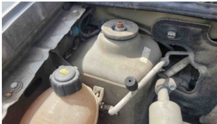
Foto Estrutura Torre do Amortecedor Direito
