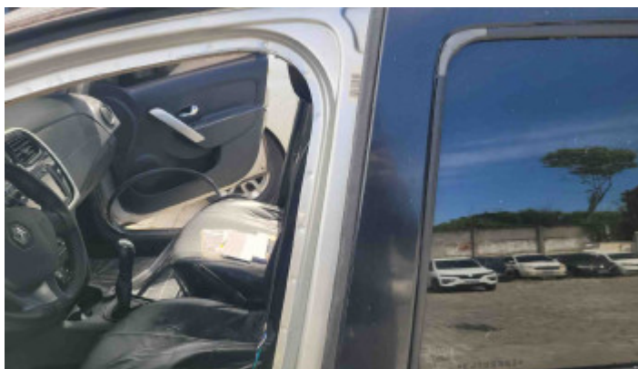
Foto Estrutura Coluna Central Esquerda
