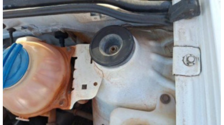
Foto Estrutura Torre do Amortecedor Esquerdo
