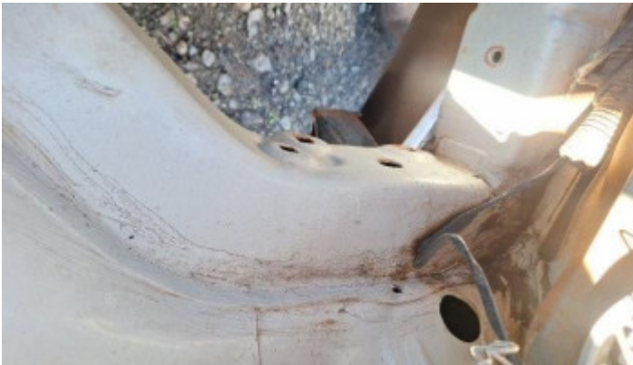
Foto Estrutura Longarina Direita
