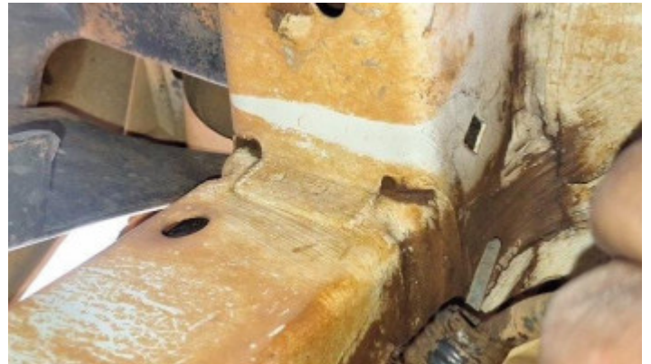
Foto Estrutura Longarina Esquerda
