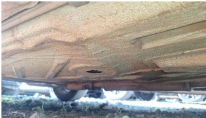
Foto Estrutura Assoalho
