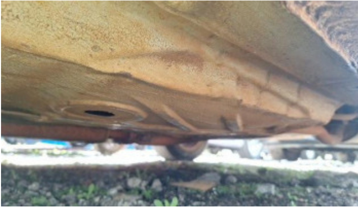
Foto Estrutura Assoalho
