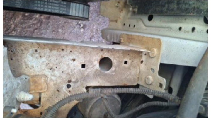
Foto Estrutura Longarina Direita
