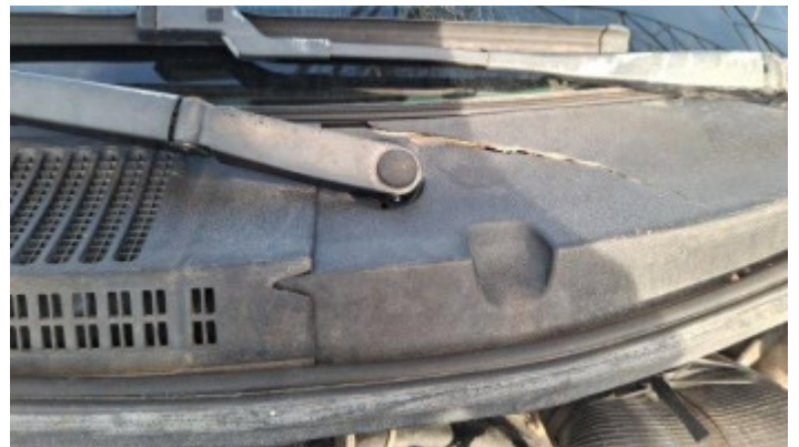
Foto Avaria Painel Corta-Fogo
