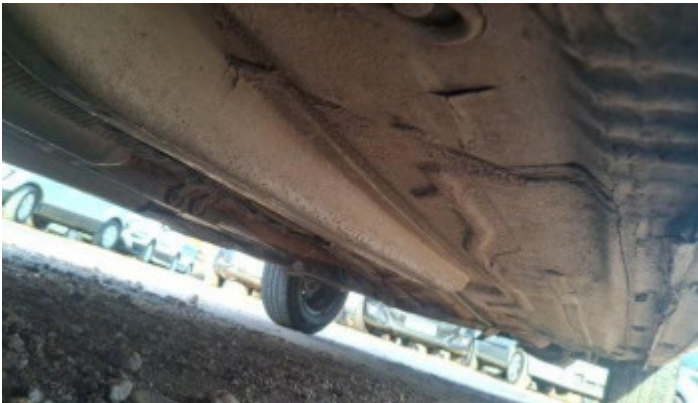
Foto Estrutura Assoalho
