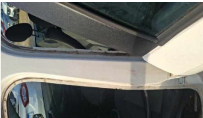
Foto Estrutura Coluna Central Esquerda
