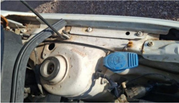
Foto Estrutura Torre do Amortecedor Esquerdo
