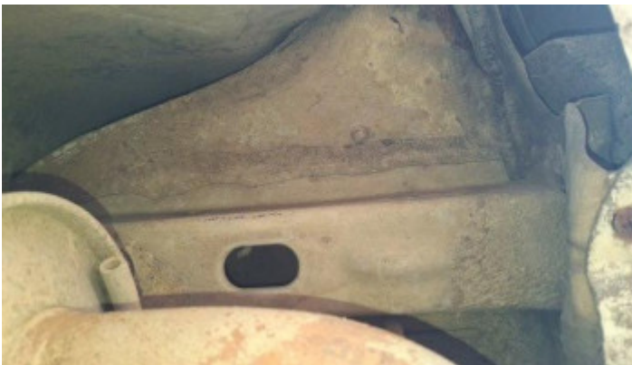
Foto Estrutura Longarina Traseira Esquerda
