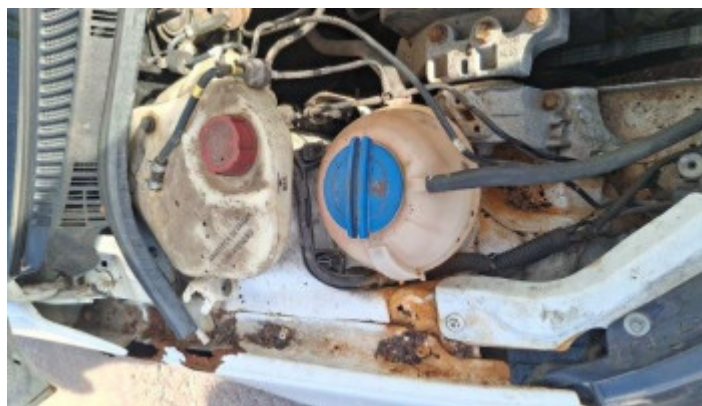
Foto Estrutura Torre do Amortecedor Direito
