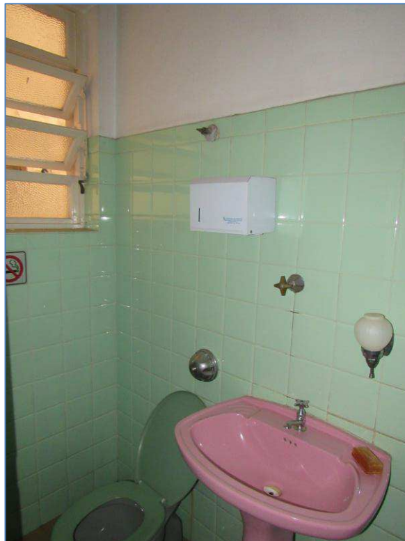
OUTRA VISTA DO BANHEIRO FEMININO.
