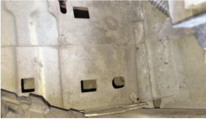
Foto Estrutura Longarina Esquerda
