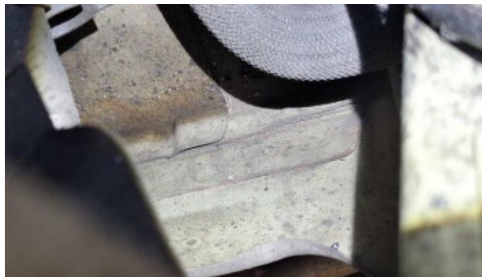
Foto Estrutura Longarina Direita
