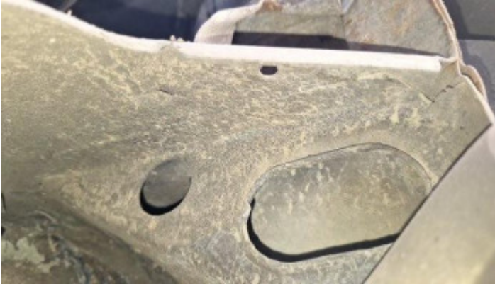
Foto Estrutura Longarina Traseira Esquerda
