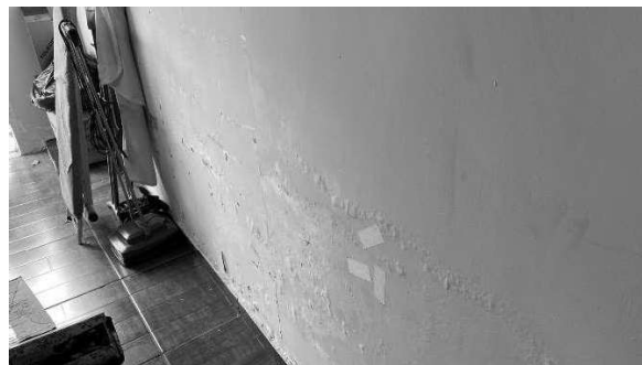
Pontos de umidade (não Averbado)
