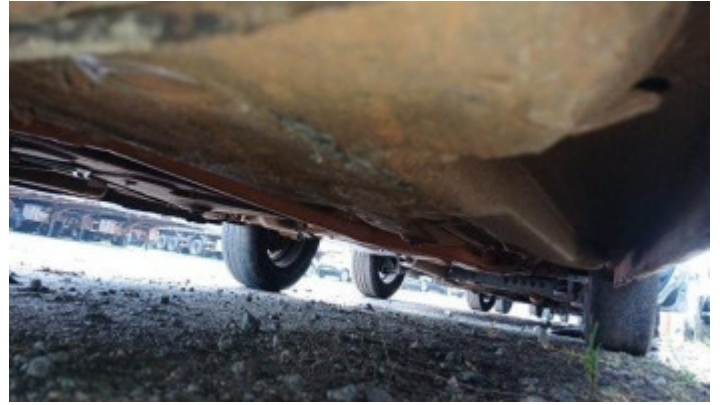
Foto Estrutura Assoalho
