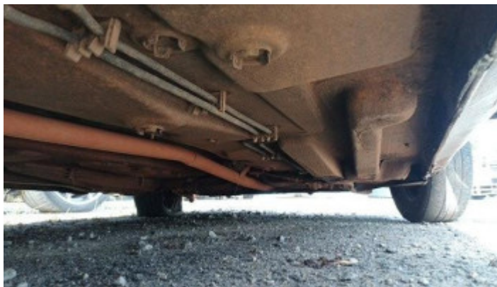
Foto Estrutura Assoalho
