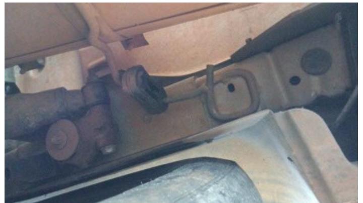
Foto Estrutura Longarina Traseira Esquerda
