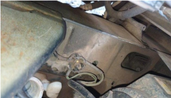
Foto Estrutura Longarina Direita
