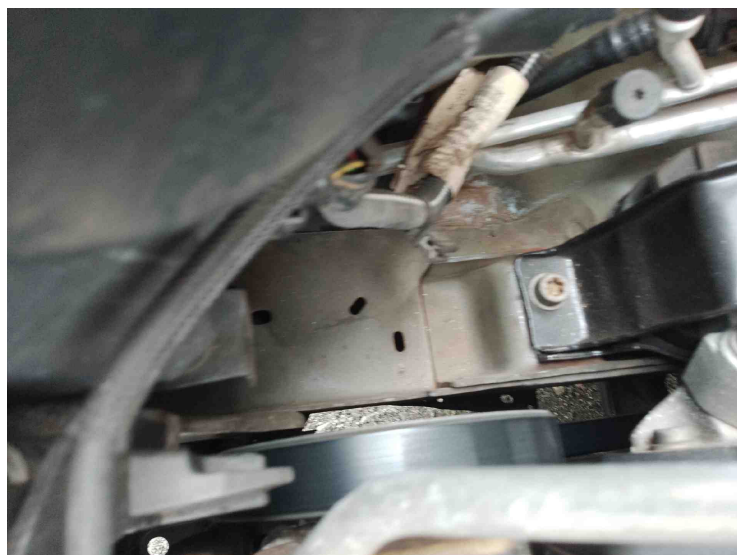
Foto Estrutura Longarina Direita
