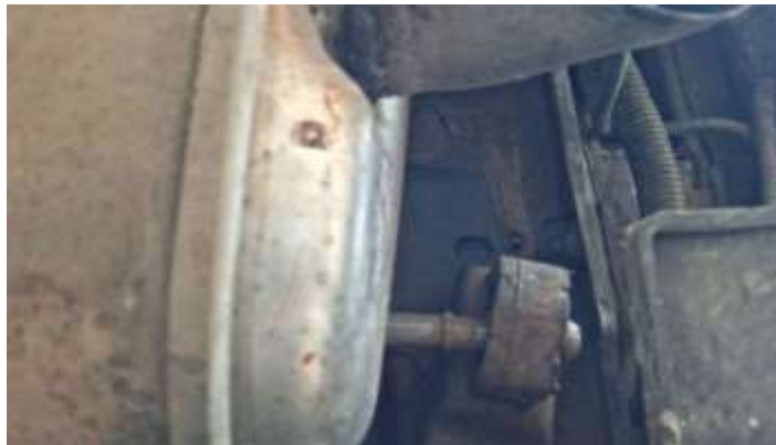
Foto Estrutura Longarina Traseira Direita
