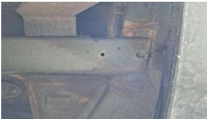
Foto Estrutura Longarina Traseira Esquerda
