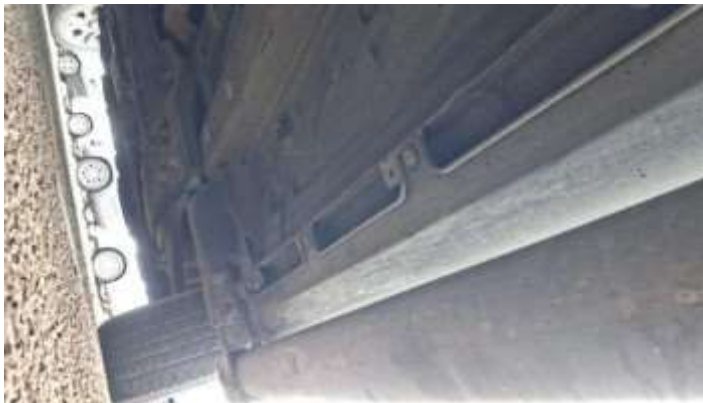
Foto Estrutura Assoalho
